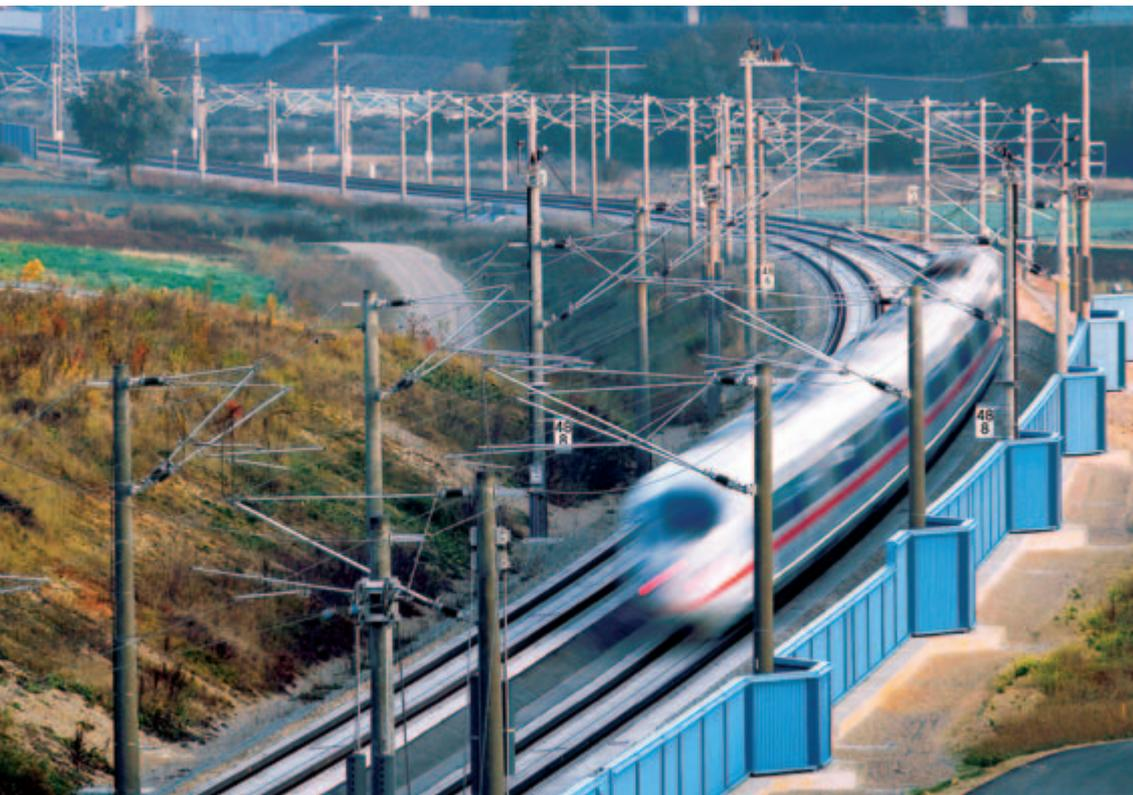
Fast 14 Kilometer Schallschutzwände wurden entlang der Neubaustrecke Nürnberg–Ingolstadt gebaut; hier: Schallschutzwände im Altmühltal bei Großhöbing
