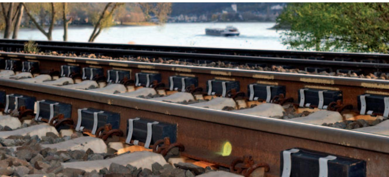
Schienenstegbedämpfer bei einem Regeloberbau mit Schotterbett im Mittleren Rheintal
